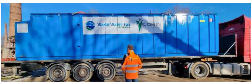
Station d'épuration WasteWaterBox de chez Cohin Environnement équipée du procédé biologique UniBiocell®.
