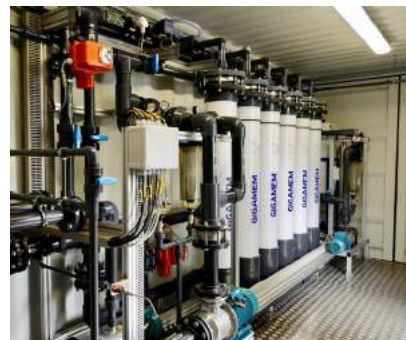
Unité d'ultrafiltration Polymem 25 m 3 /h en container 20 pieds / partenariat Sotrad, pour production d'eau potable pour la Côte d'Ivoire.
