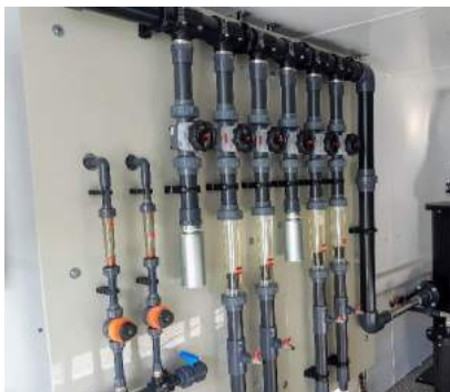
Unité mobile de dépollution par extraction des gaz du sol in-situ Ortec Soleo.
