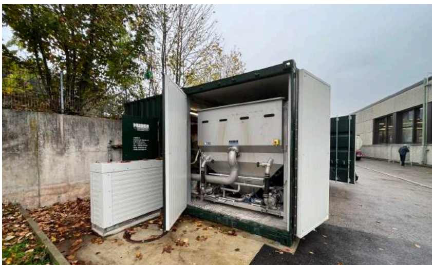
Un flottateur HDF 4S HUBER sur le site de la fromagerie Windsbach (Allemagne), qui avait besoin d'une solution rapide pour limiter ses rejets et maintenir sa production.
