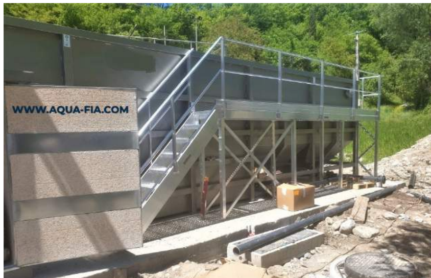
Station Haute capacité MBBR 225 - capacité 1500 Équivalent habitants de chez France Industries Assainissement.
